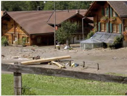
Schäden in Reichenbach, ausgelöst durch das Hochwasser (Foto: Berner Zeitung online, ZVG 2005)
