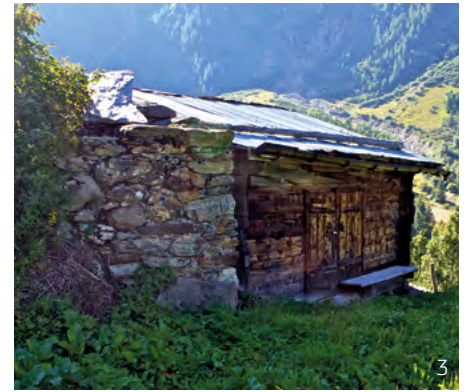
Abbildung 3: Lawinenschutz aus Fels und Stein: Gerade in engen Tälern wie dem Lötschental mussten die Bewohnerinnen und Bewohner landwirtschaftliche Gebäude teilweise in lawinengefährdeten Gebieten erbauen. Diese Stallscheune im Einzugsgebiet der «Gerynloibina» (Geryn-Lawine) wurde deshalb hinter einem Felsblock erbaut, welcher zusätzlich ummauert wurde. Im Falle des Niedergangs einer Lawine dient diese massive Rückwand als Keil, welcher die Lawine teilt. Dadurch fliesst die Lawine rechts und links am Gebäude vorbei, ohne nennenswerten Schaden anzurichten. (Foto: R. Schmid)
